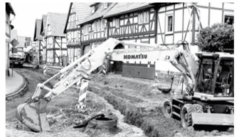
Sanierung der Ortsdurchfahrt von Frieda.
