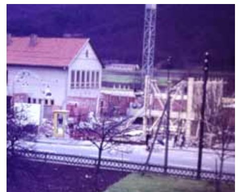
Zwei tolle Kurzfilme zeigten den Bau der Weinberghalle in den Jahren 1969 bis 1971.
