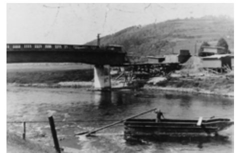
1954 fanden Reparaturarbeiten an der Brücke statt. In dieser Zeit nahm Horst Mangold vorübergehend den Fährbetrieb wieder auf.
