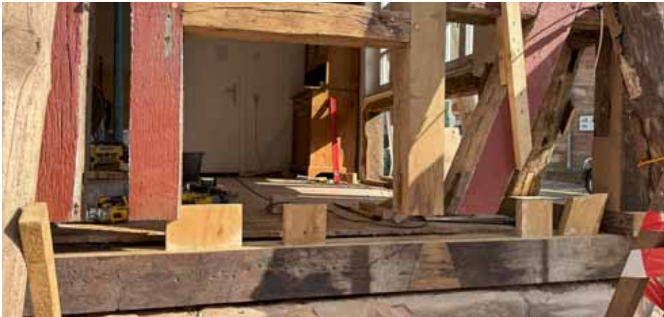
Einfädeln der neuen Giebelschwelle
