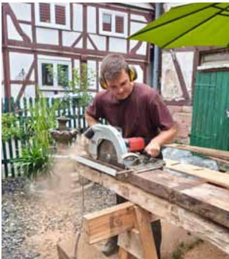
Zuschnitt der Hölzer mit der Handkreissäge
