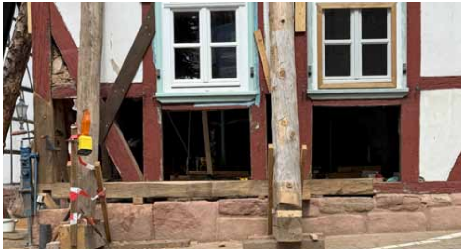
Die Traufseite mit der neu eingesetzten Schwelle
