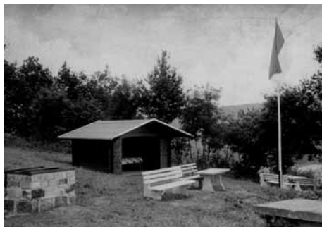
Die Freizeitanlage am Kahlenberg in Frieda kurz nach ihrer Fertigstellung im Juli 1975.
