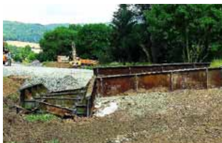
Die Reste der 1906 erbauten und 2014 abgerissenen Eisenbahnbrücke über die Frieda.
