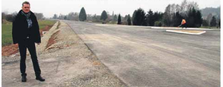
Radweg endet hier: Bernd Göke vom ADFC Werra-Meißner steht am Ende des Radwegs, der von Wanfried nach Frieda führt und vor dem Meinharder Ortsteil über die neu geführte Bundesstraße 249 verläuft. Wenige Meter später passiert die Radtrasse - dort, wo der Bauarbeiter zu sehen ist - auch die Zubringerstraße (rechts).
