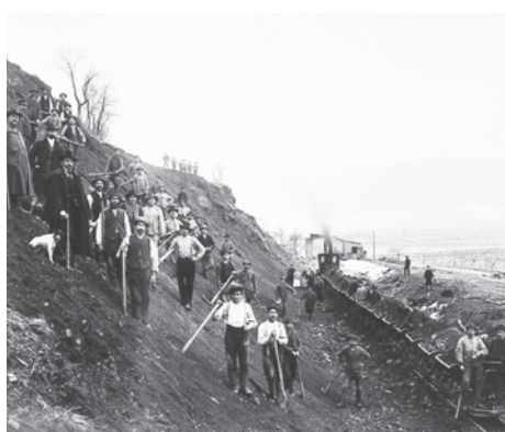
Bahnarbeiten am Weinberg zwischen Frieda und Schwebda, wo heute der Radweg verläuft.
