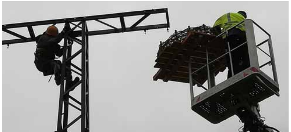
Unmittelbar bei der Frieda-Mündung in die Werra wurde in luftiger Höhe gearbeitet.
